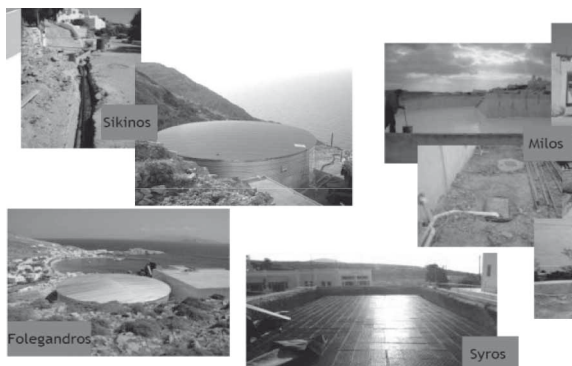
Εικόνα 5: Εγκαταστάσεις ανάκτησης βρόχινου νερού στις Κυκλάδες
