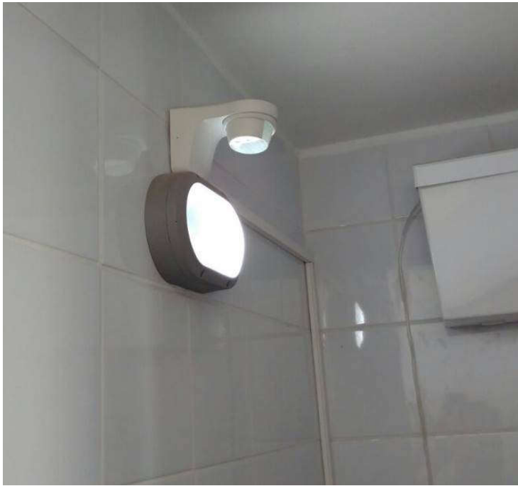
αισθητήρας κίνησης στην τουαλέτα των μαθητών
